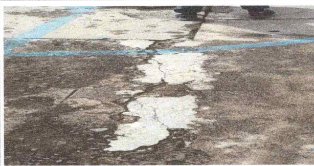
Foto 2: Sustrucción de piso de torta de concreto
