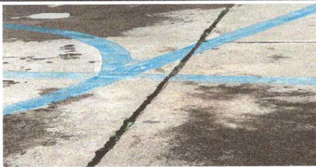
Foto 3: Sustrucción de piso de torta de concreto
