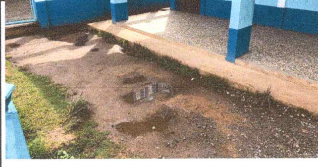
Foto 6: Sustrucción de torta de concreto
