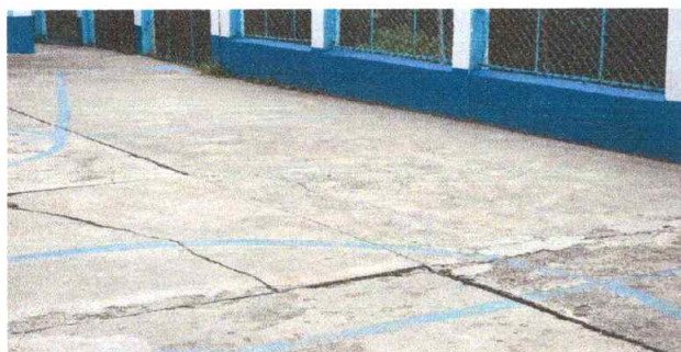
Foto 9: Sustrucción de piso de torta de concreto.
