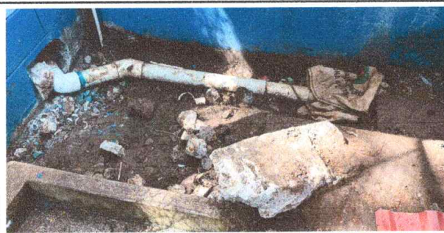
Foto 5: reparacion de piso de torta de concreto.
