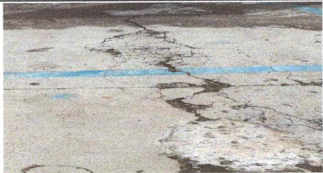
Foto 1: Sustrucción de piso de torta de concreto
