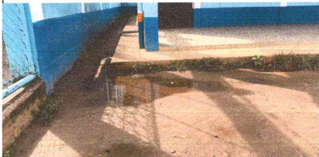
Foto7: Sustrucción de torta de concreto
